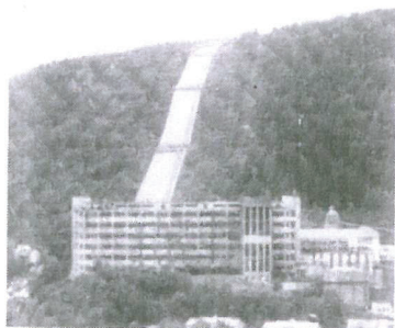
Fig. 237. Norges største vandkraftanlæg, Rjukan. Anlagt i 1910. Producerede tungt vand. Vandets faldhøjde er 300 m.
